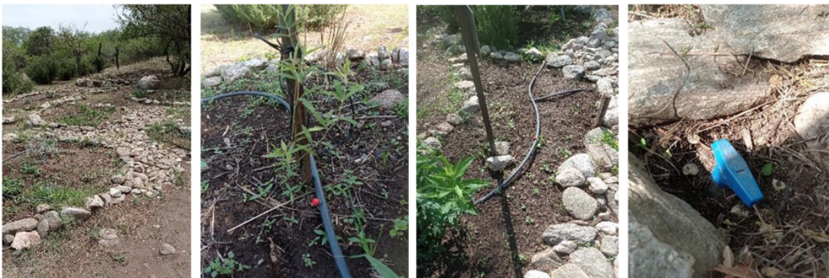
Figura 3. Instalación de riego por goteo: mangueras, goteros en canteros y llave de paso instalada a la entrada del jardín
